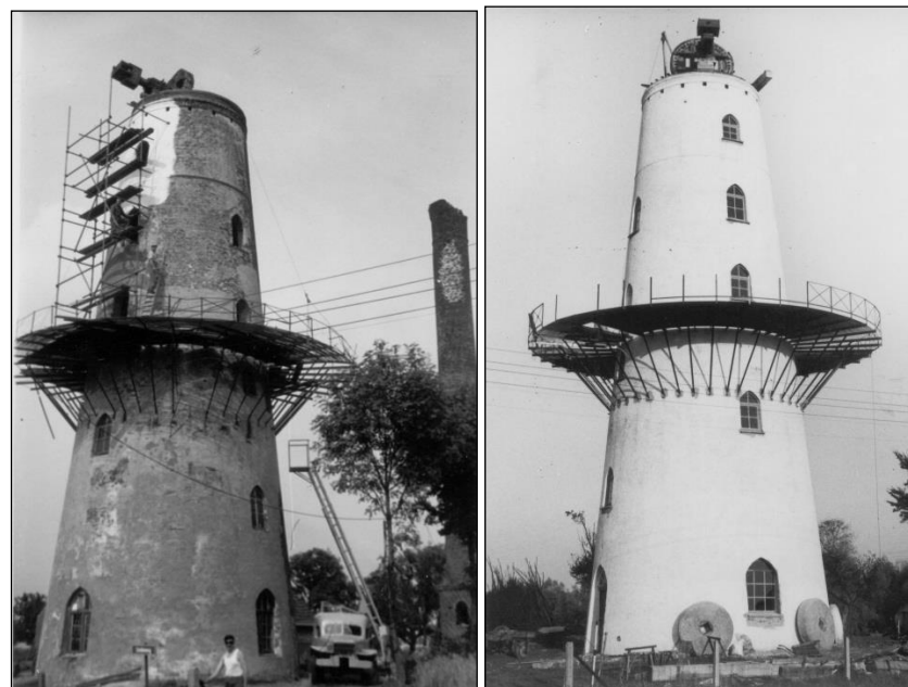
De Couchezmolen tijdens de restauratie in 1967-1968.
