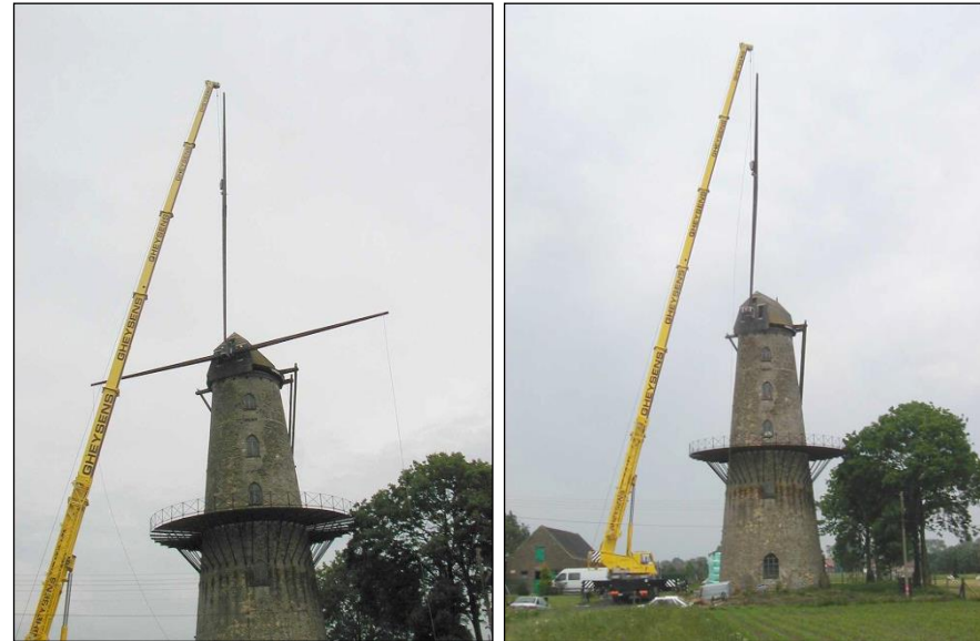
Het uittrekken van de wieken in juni 2002. (Fotografie: Christiaan Debusschere)
