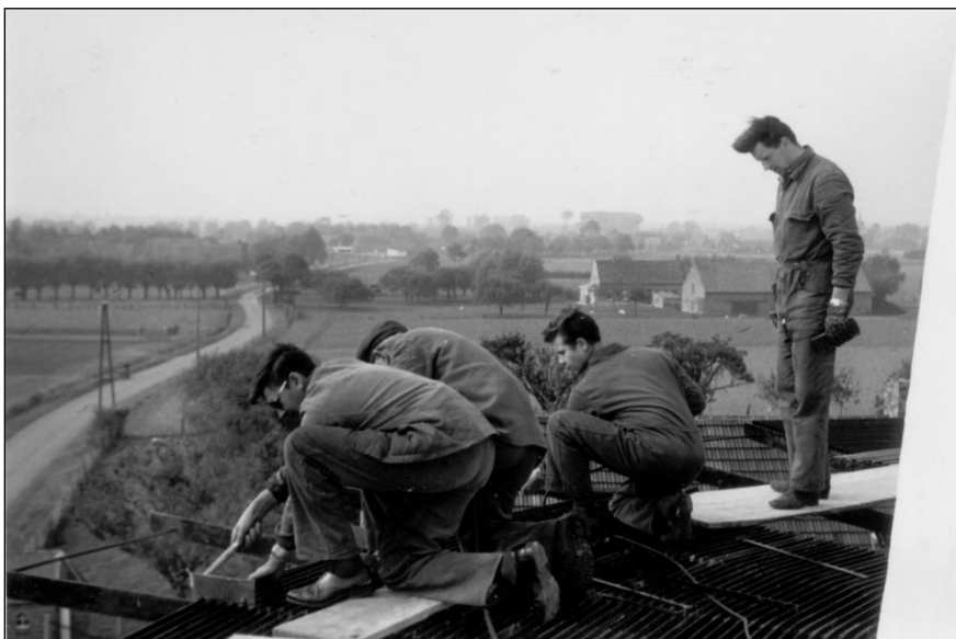
Het plaatsen van de nieuwe stelling of gaanderij.
