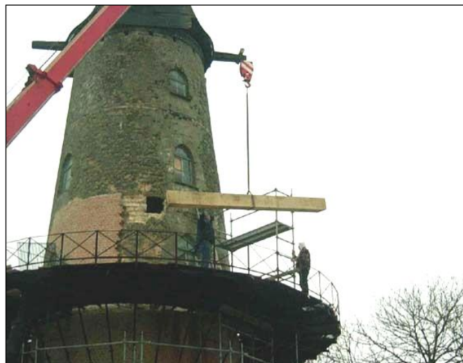
Het insteken van nieuwe moerbalk op de steenzolder in januari 2003. (Fotografie: Christiaan Debusschere)
