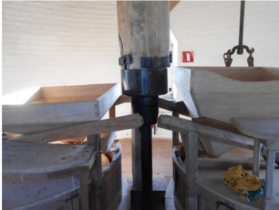
Twee maalstoelen met centraal de deels houten deels ijzeren koningsas.
