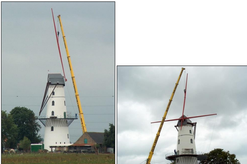
Het monteren van de buitenroede en de binnenroede met een telescopische kraan in augustus 2003. (Fotografie: Christiaan Debusschere)
