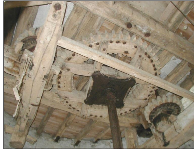
Het spoorwiel en de twee kamwielen voor de onderaandrijving van de twee steenkoppels.
