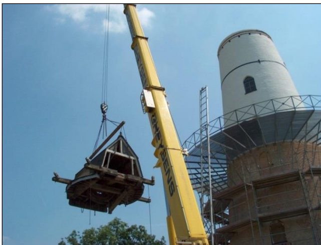
Het afnemen molenkap (8 ton) met een telescopische kraan in juni 2003.
