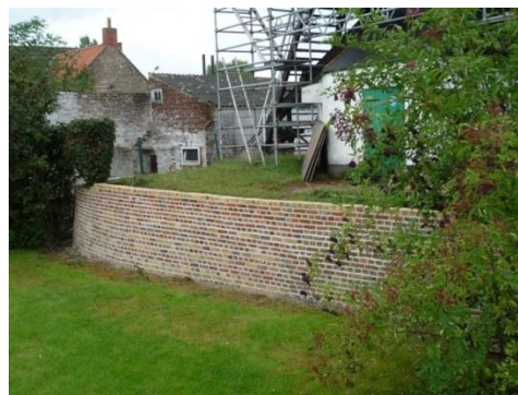
Tijdens de restauratie van 2010-2011 herstelde keermuur.
