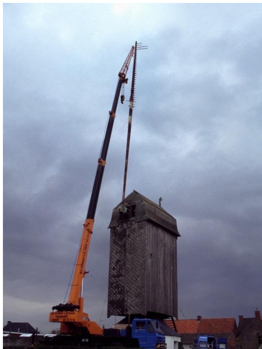
Het steken van de aangepaste roeden in de Kruisstraatmolen.
