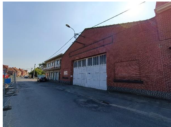
Foto 26: Voorgevel te behouden loods
