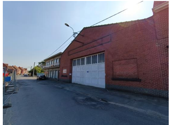
Foto 24: Te behouden kantoor en loods.
