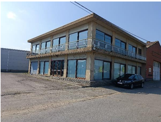
Foto 25: Te behouden kantoorgebouw
