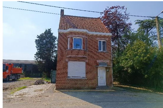
Foto 2: Woning naast inrit droogloods
