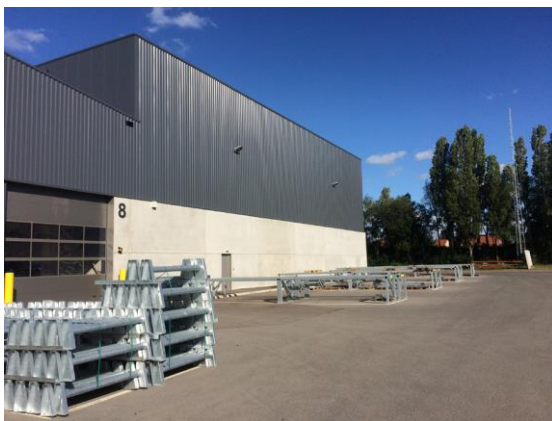
Foto 6: Zicht vanaf betonverharding op zuidelijke loods Deprez
