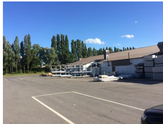
Foto 5: Zicht vanaf betonverharding op achtergelegen loods Opmetaal
