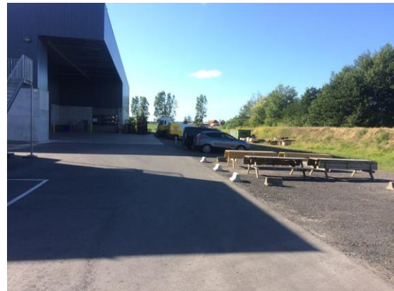
Foto 13: Zicht op achterzijde montagehal Deprez Construct met bijhorende parking
