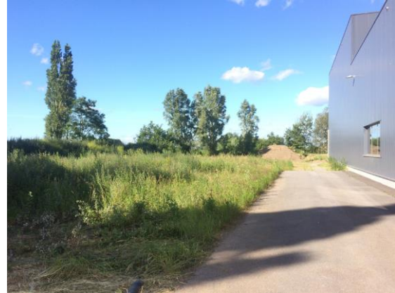
Foto 9: Zicht op meest noordoostelijke loods Deprez vanaf noordwestelijke brandweg
