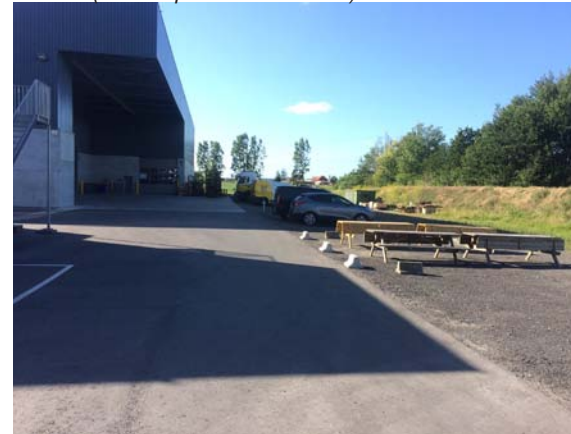
Foto 13 (bron Deprez Construct NV)
