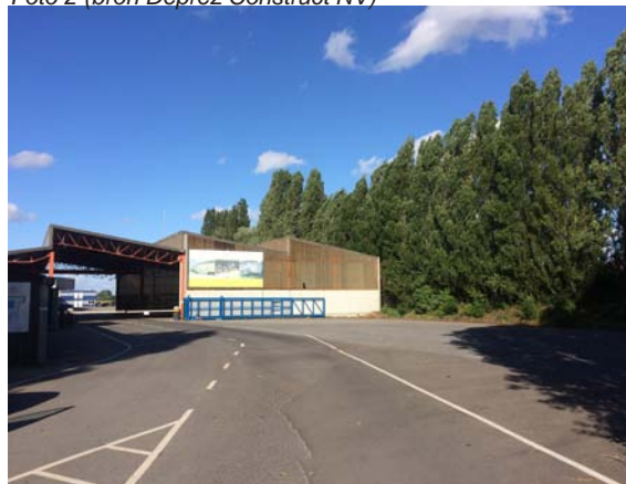
Foto 2 (bron Deprez Construct NV)
