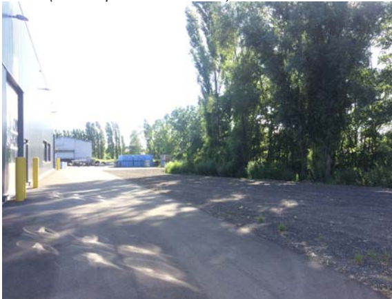
Foto 10 (bron Deprez Construct NV)
