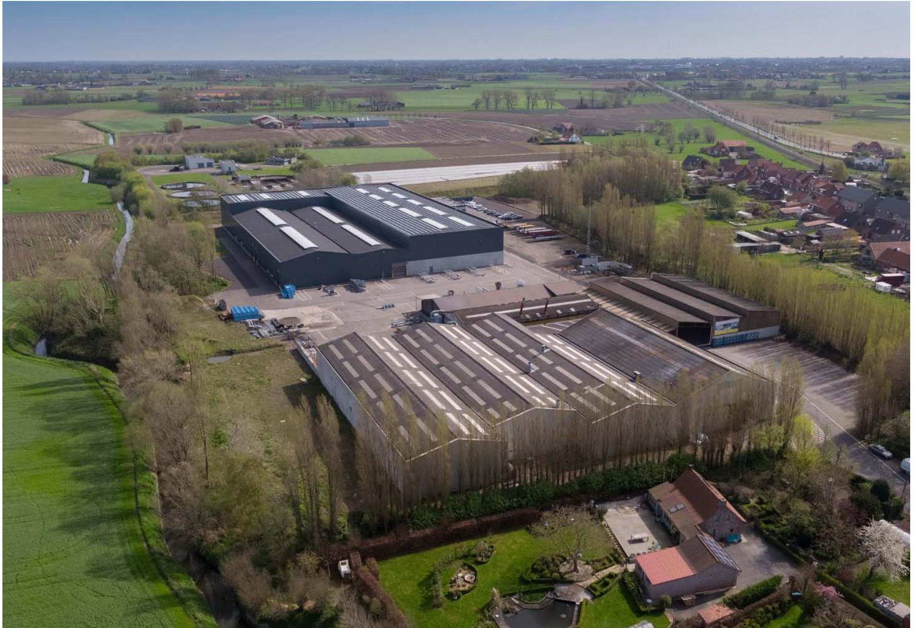
Foto (bron Deprez Construct NV)
