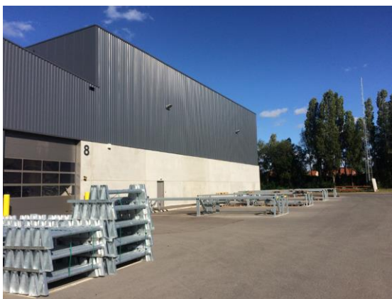
Foto 6: Zicht vanaf betonverharding op zuidelijke loods Deprez
