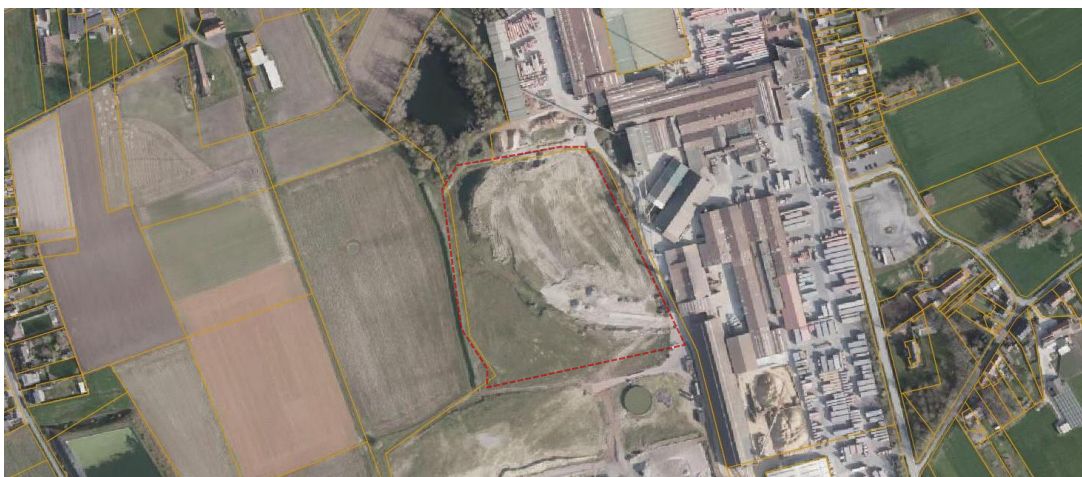
Figuur 18: Meest recente luchtfoto 2021 (bron Geopunt)
