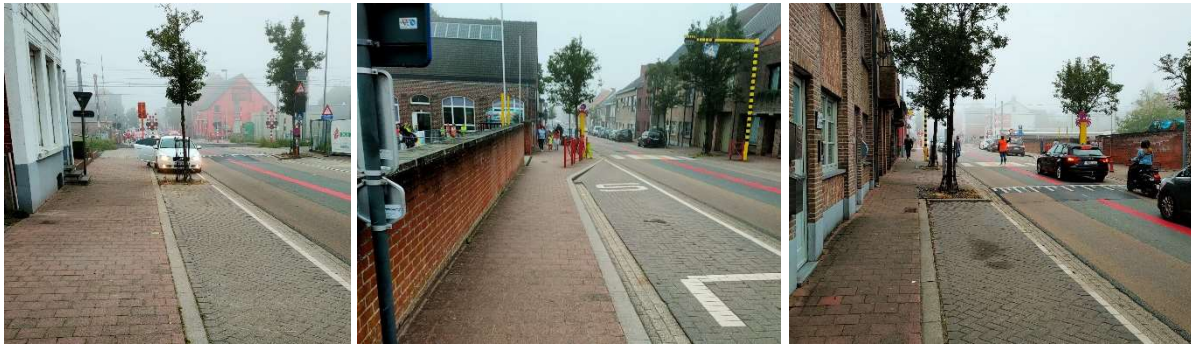
Figuur 7: Voetgangersvoorzieningen Kronevoordestraat
